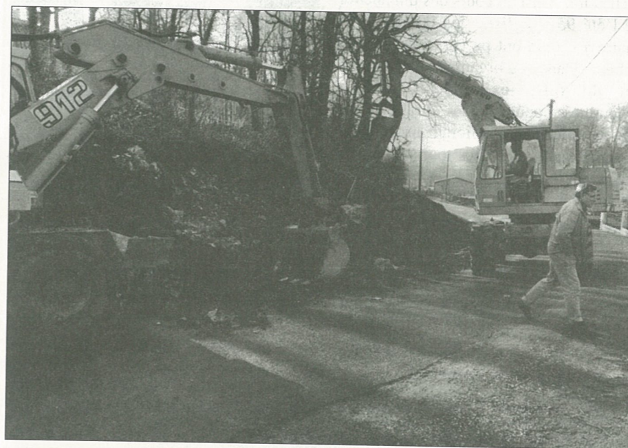
Travaux : Route de Fouquebrune
