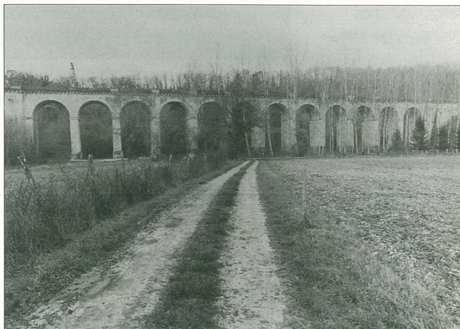
Viaduc SNCF des Couteaubières
