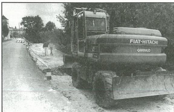
Au virage du pigeonier, le Conseil Général a lancé le chantier.
