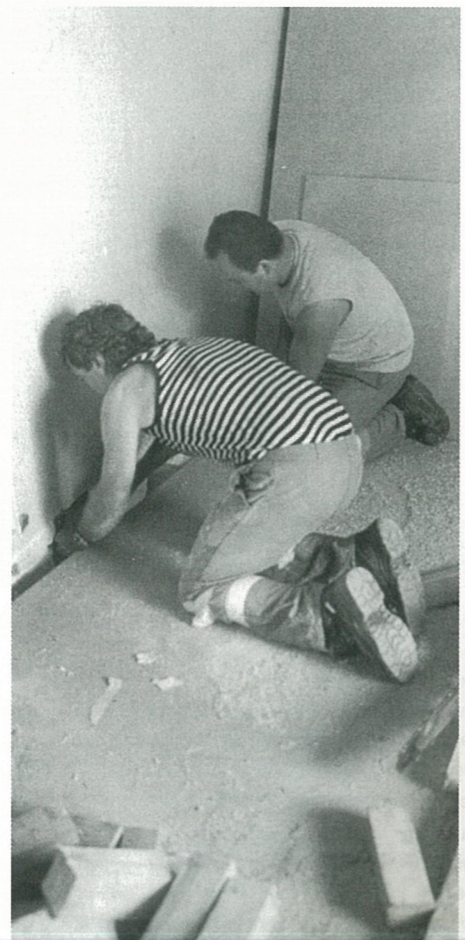
Travaux au presbytère Photo Alain PORTE
