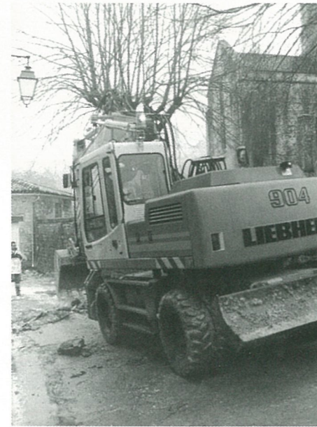
Travaux à la pelle... mécanique dans les rues du bourg.
