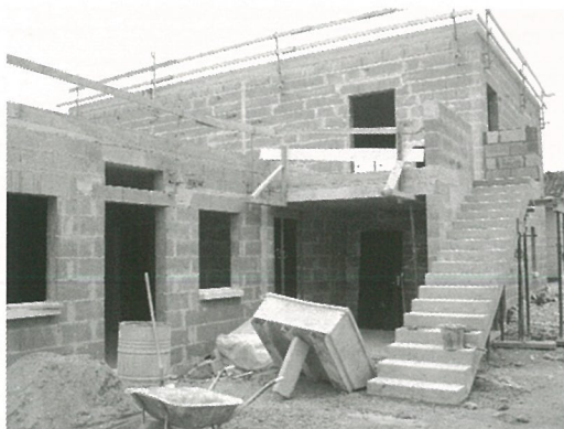
Le chantier du Foyer avance bien (Photos Alain PORTE)
