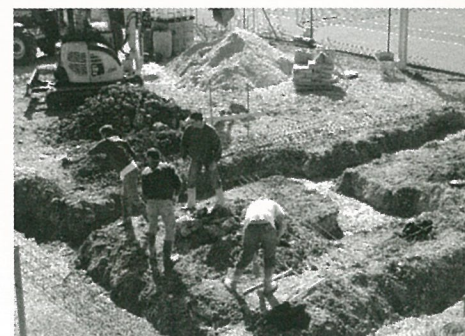
Le chantier du Club House Tennis a commencé (Photo Alain PORTE)
