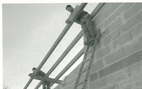
Le club house bien charpenté
