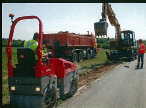
Travaux sur la route de la Foy au Rosier ; le revêtement final viendra en 2012.
