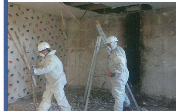
Démolition des logements sociaux par la commune
