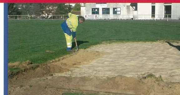
Réfection du bac à sable autour du stade
