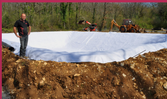
Aménagement des bassins de traitement des boues de résidus d'assainissement de la société Monastérienne Assainivert
